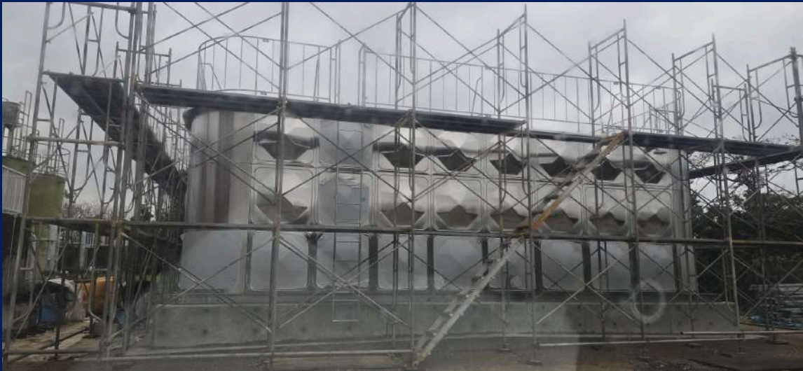
Paslanmaz modüler kaynaklı su deposu — saha montajı / stainless modular welded water tank, site assembly
